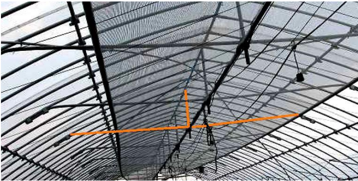
写真1 タイバー設置の例
