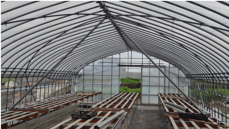
写真11 斜め支柱設置の例
